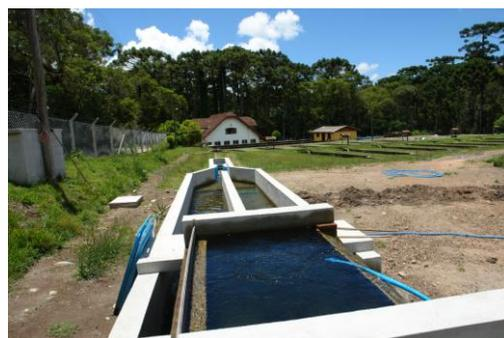
Figura 3 – Módulo de tratamento da água de abastecimento: vista da caixa de recepção e tanque de decantação.
