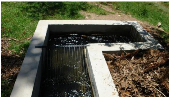
Figura 2 – Grade de ferro com vãos de 2,5 cm no ponto de captação da água do rio, para retenção de material grosseiro.
