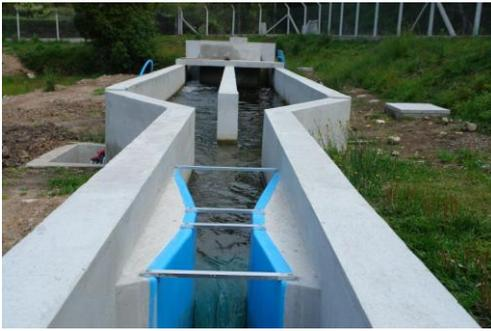
Figura 4 – Módulo de tratamento da água de abastecimento: vista do tanque de decantação e da calha Parshall.
