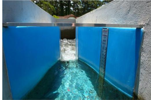
Figura 9 – Calha Parshall com graduação em m<sup>3</sup>/hora
