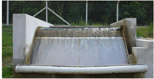
Figura 5 – Vista da água vertendo da caixa de recepção sobre a tela de filtragem.
