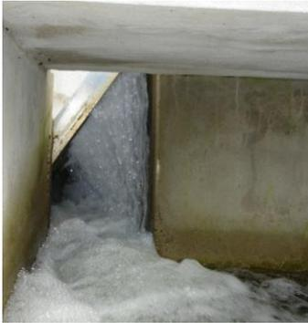
Figura 8 - Passagem da água pela tela de 1 mm em direção aos tanques de decantação.
